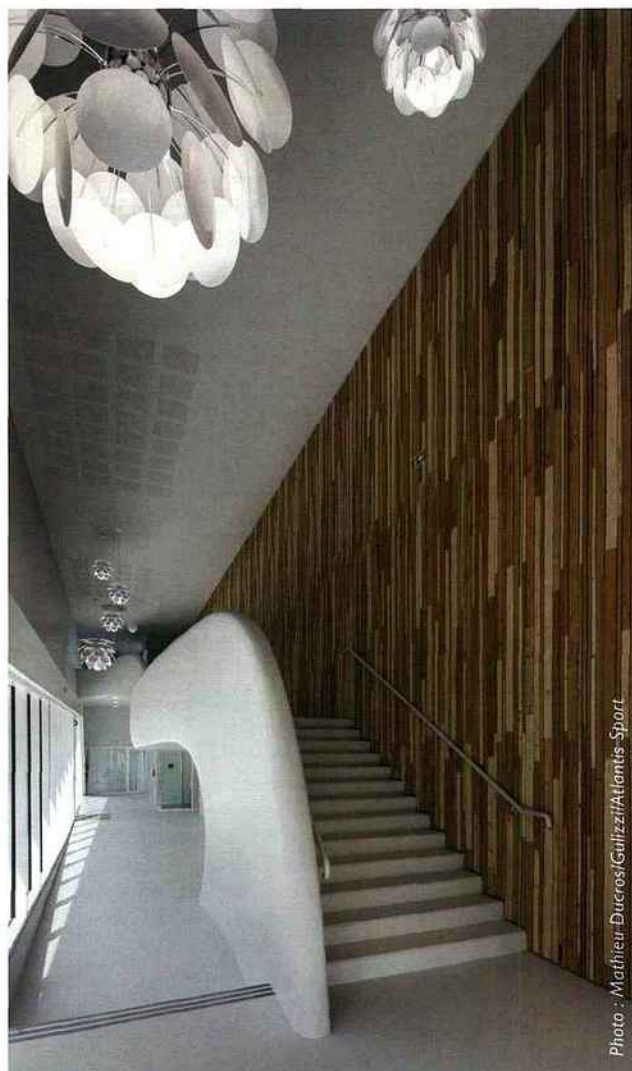
▶▼ Sous les tribunes et face à l'escalier menant du hall d'accueil aux gradins, le parement du mur est constitué de modules de bois d'essences différentes, assemblés verticalement en quinconce, sans joint visible.
