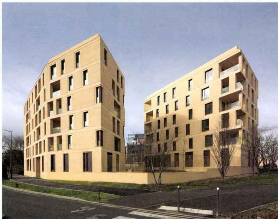
Ci-dessus et page de droite : la matérialité des façades, un béton teinté dans la masse, s'apparente à la pierre calcaire par sa couleur et sa texture bouchardée. Il est rehaussé de finitions
