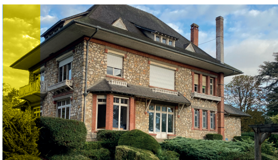
Marly-le-Roi Réhabilitation et extension du Conservatoire Roger Bourdin.
