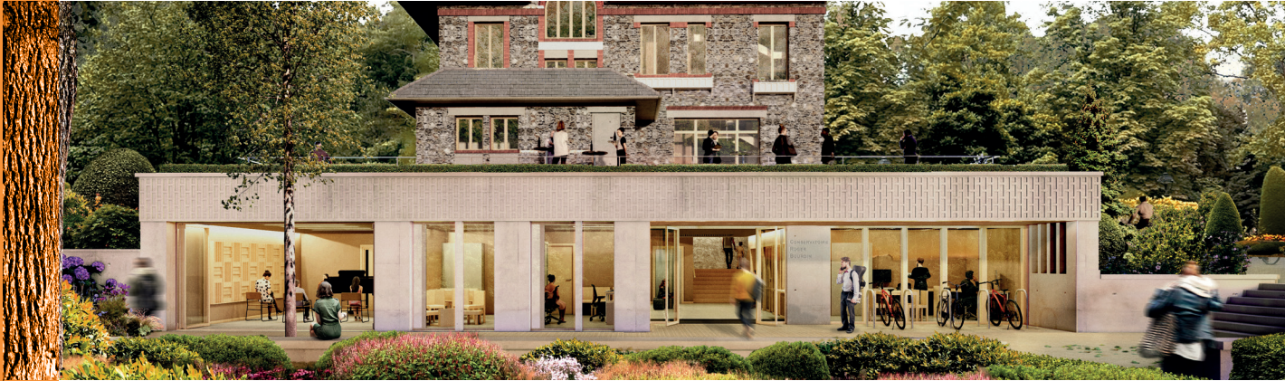
Réhabilitation et extension du conservatoire de musique Roger Boudin à Marly-le-Roi NUNC architectes
