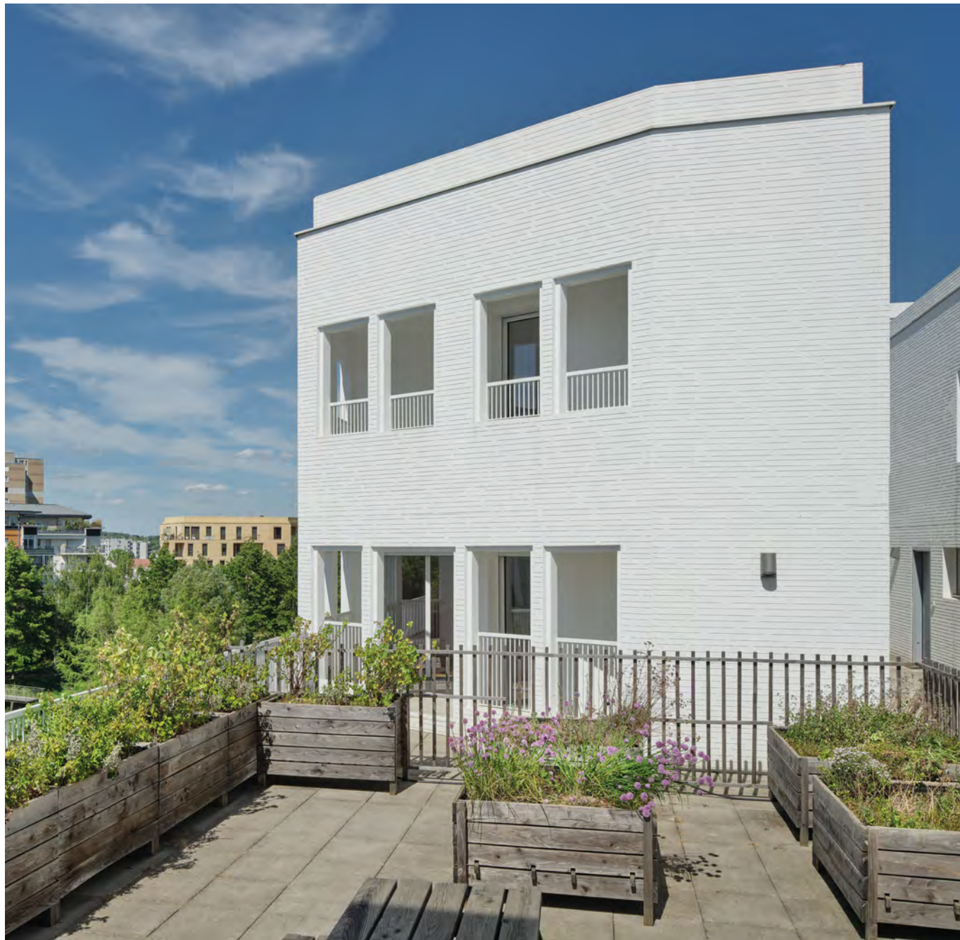
Sur les hauteurs du projet de SOA «Habiter le ciel» (au R+4), quelques volumes manquent et laissent place à des jardins partagés.
