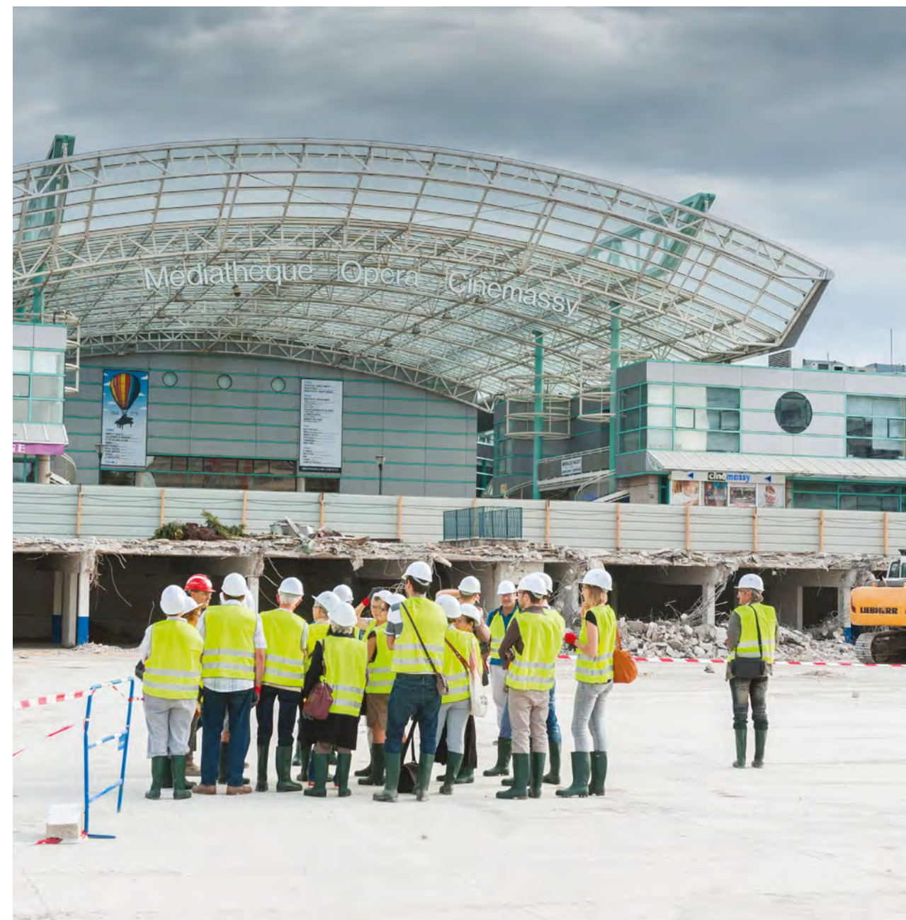
Visite de chantier des travaux de la phase 1, septembre 2014
