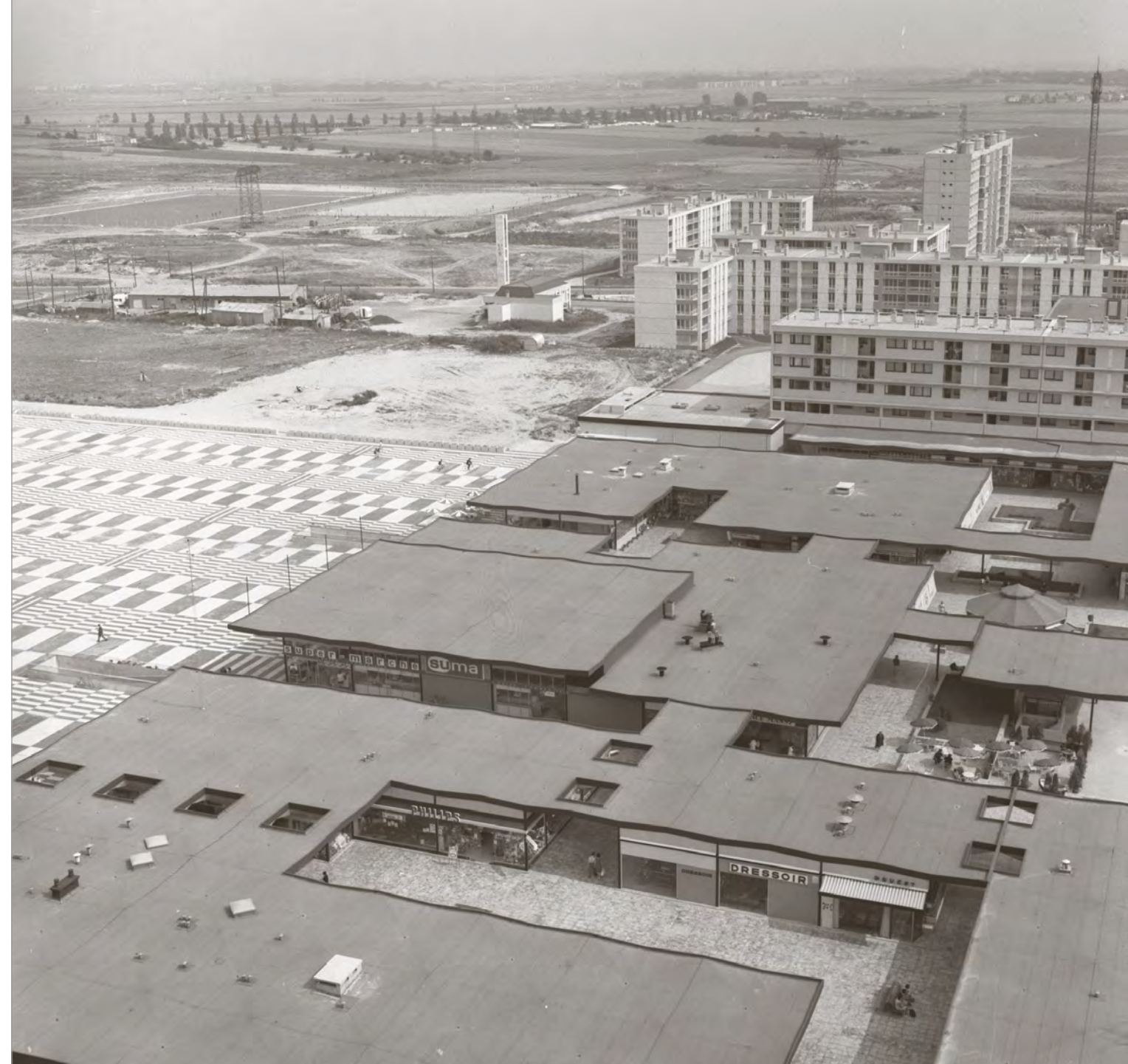
Vue aérienne du centre commercial, 1966
