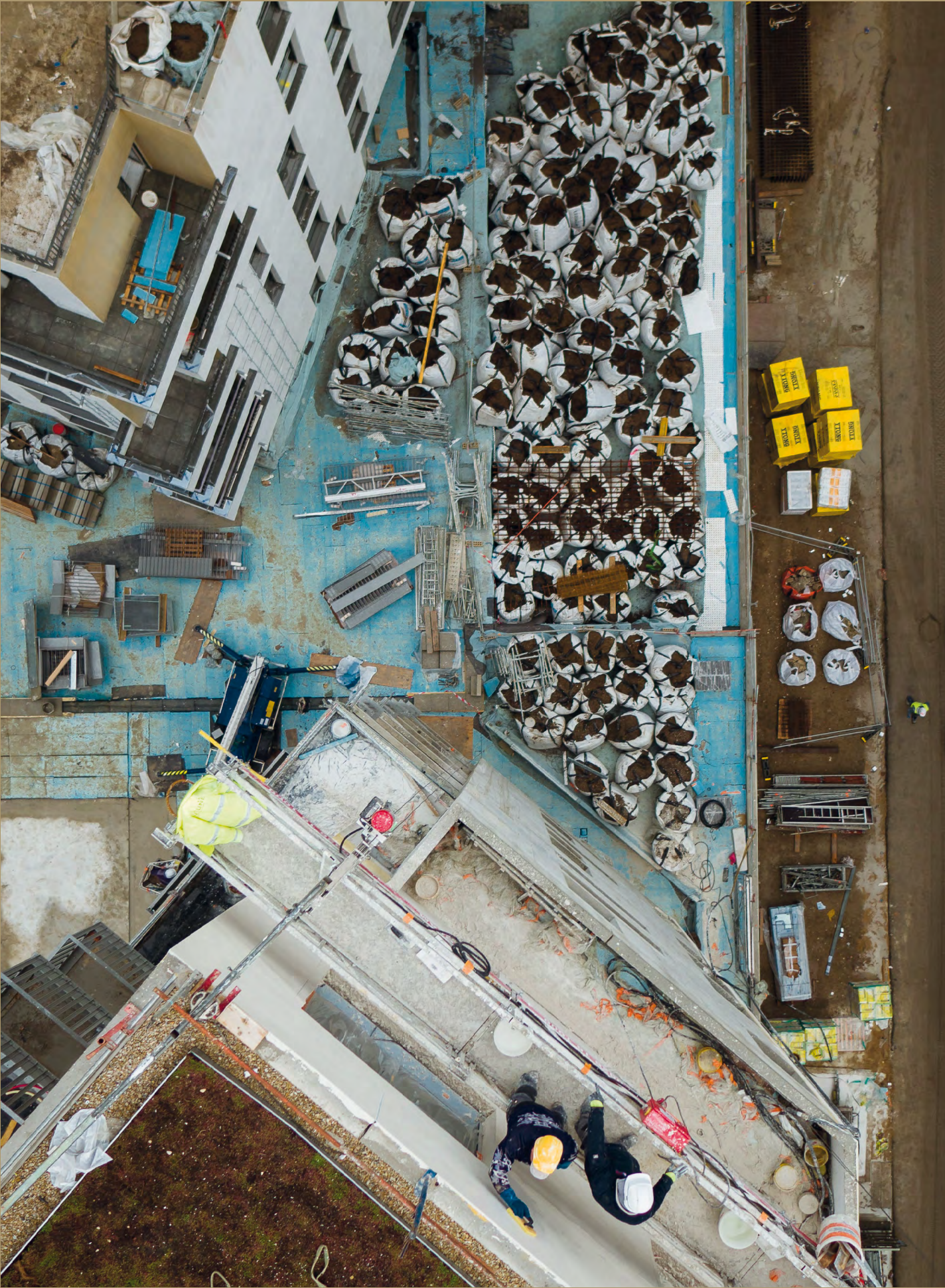
VUE AÉRIENNE DU CHANTIER AMBITIEUX ET COMPLEXE DE LA PLACE DU GRAND OUEST
